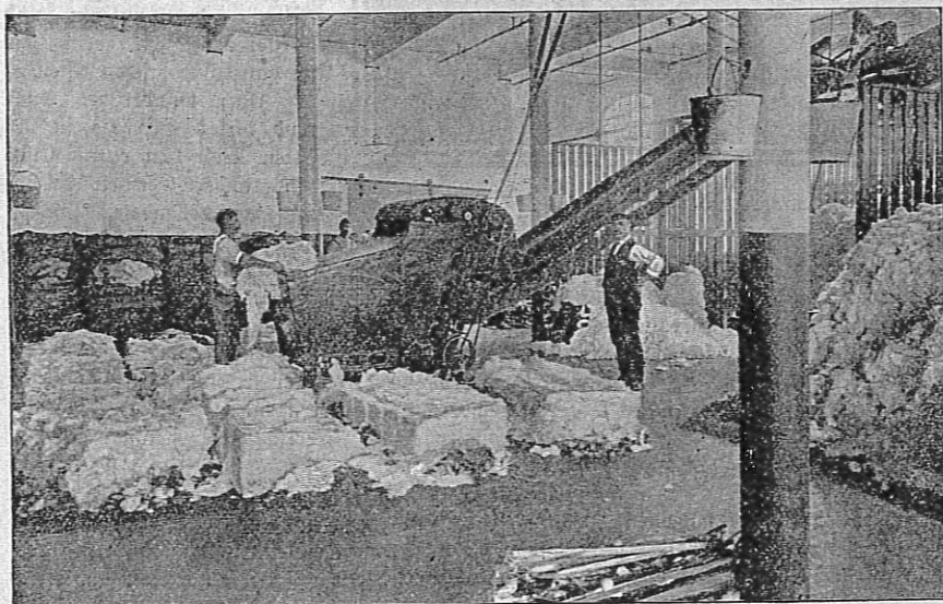
Die Rohbaumwolle wird durch eine Maschine gereinigt und geglättet.
